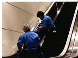
洗浄剤を含ませたシートを手すりベルトに貼り付け10分待ちます。
