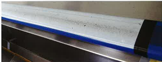
定期清掃で捕れる汚れは僅かだが、強い圧力がかかっており手すりベルト表面を痛める原因となる
