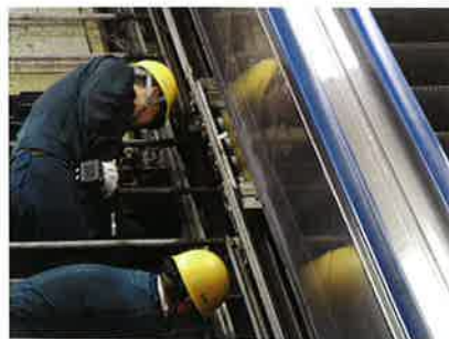
点検作業中。ここまで分解しないとローラーが見えない場合も。
